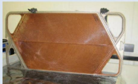
Wärmetauscherplatte vor der chemischen Reinigung
